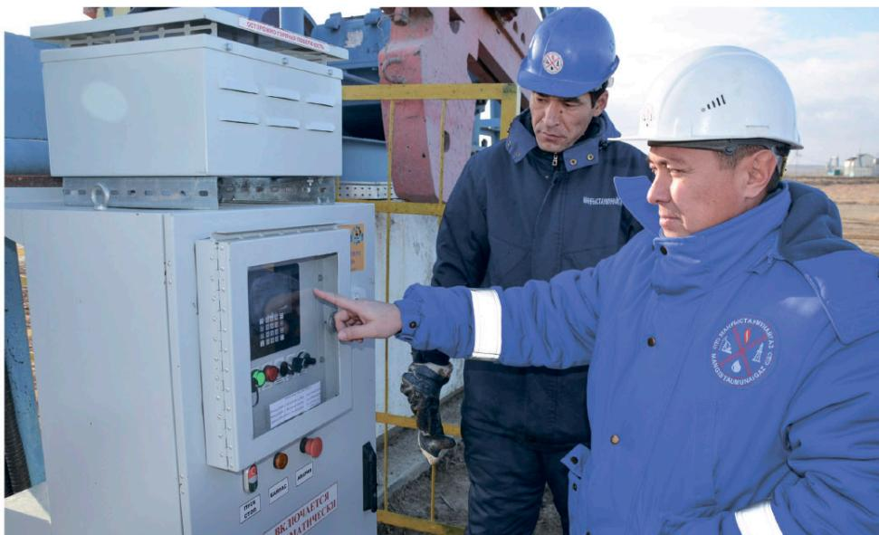
На первом этапе внедрён проект по реконструкции системы телемеханики объектов добычи месторождения Асар и оснащения системой автоматизированного управления 25 добывающих скважин. Информация с объектов в цифровом формате передается в диспетчерскую ЦДНГ-3 производственного управления «Жетыбаймұнайгаз». В случае если нововведение по 25-ти скважинам признают успешным, то в течение ближайших двух-трех лет проект планируется поэтапно реализовать и на других месторождениях Общества.
